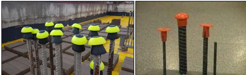
**Ilustración 26. Cápsulas de protección.**
