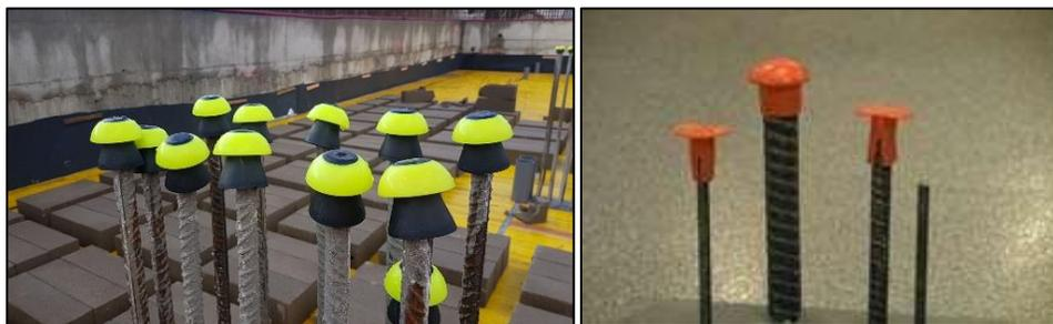
**Ilustración 45. Cápsulas de protección.**
