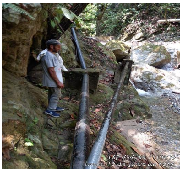
Ilustración 5. Daños a la línea de conducción y uniones de tubería de PVC ala HG
