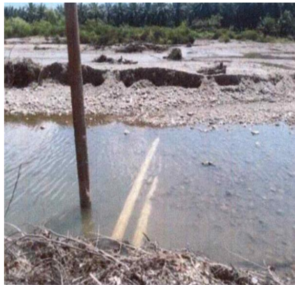
Ilustración 8. Cruce subterráneo del Río Guaymón
