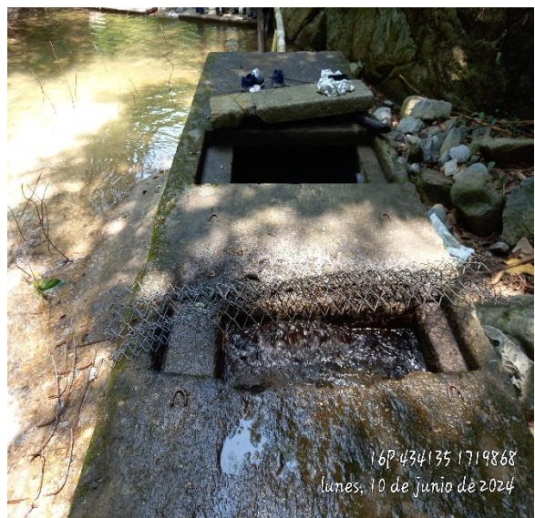
Ilustración 4. Infraestructura del desarenador en mal estado.
