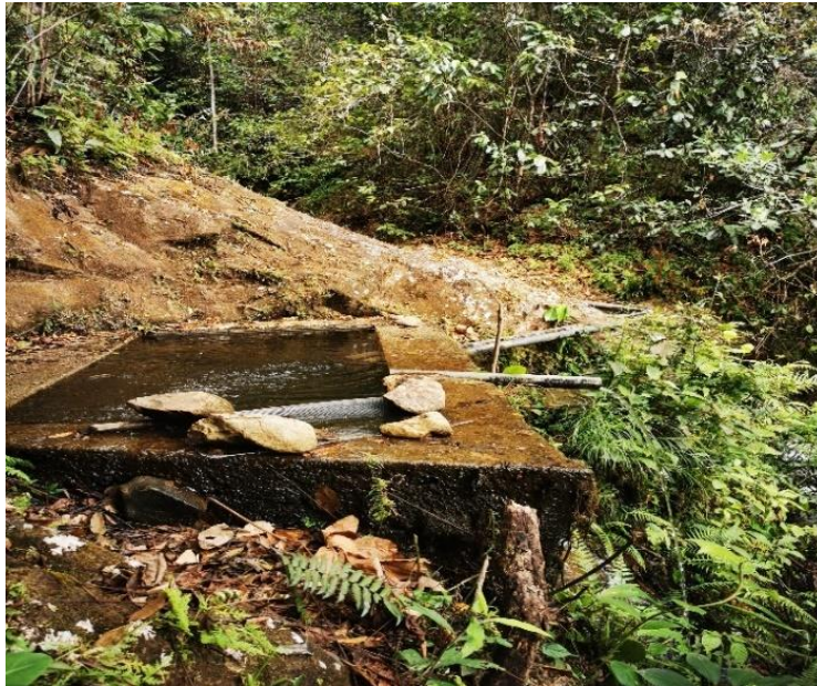
Ilustración 10. Sitio de obra toma de Yorito.
