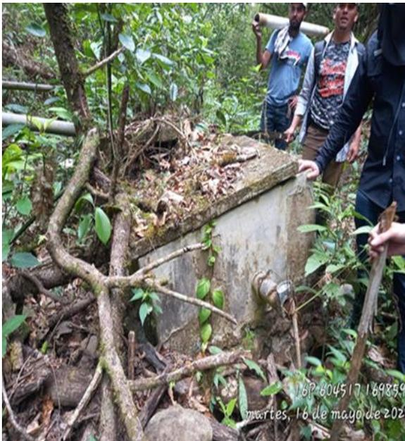
**Ilustración 11. Estado actual del Desarenador**
