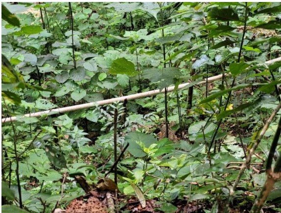
Ilustración 9. Tubería de conducción sostenida con ramas y sin ningún tipo de apoyo.
