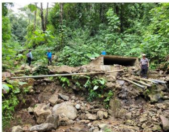
Fotografía 1: Obra de Captación La Consuelo de Planes de Italia
