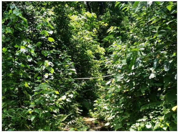
Ilustración 9. Tubería de conducción sostenida con ramas y sin ningún tipo de apoyo.
