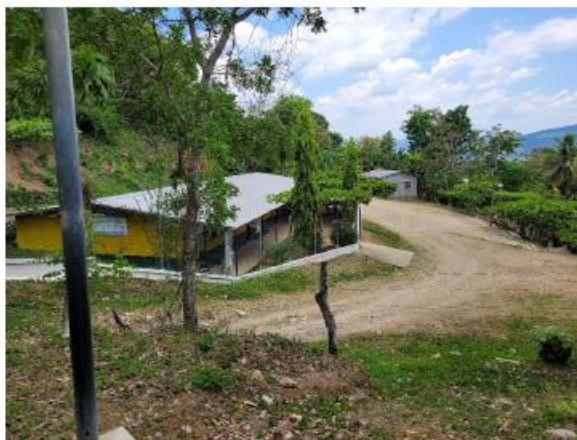
Fotografía 8: Escuela Juan Alberto Melgar en Caleras
