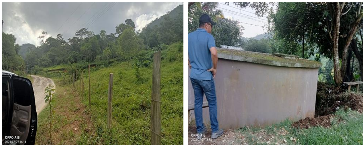
Ilustración 5. Tramo donde pasa existente en línea de conducción- Tanque de Almacenamiento
