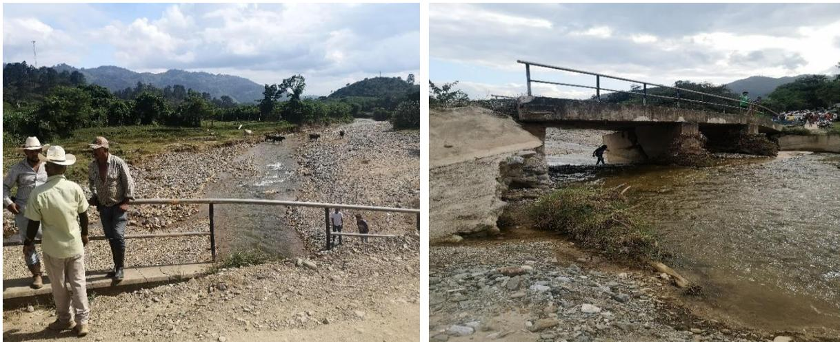
**Ilustración 4. Afectaciones aguas abajo y daños en los barandales del puente.**
