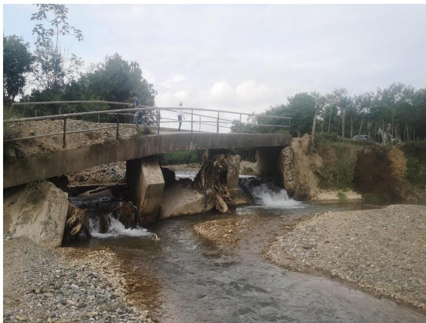
**Ilustración 6. Afectaciones en los apoyos intermedios del puente**
