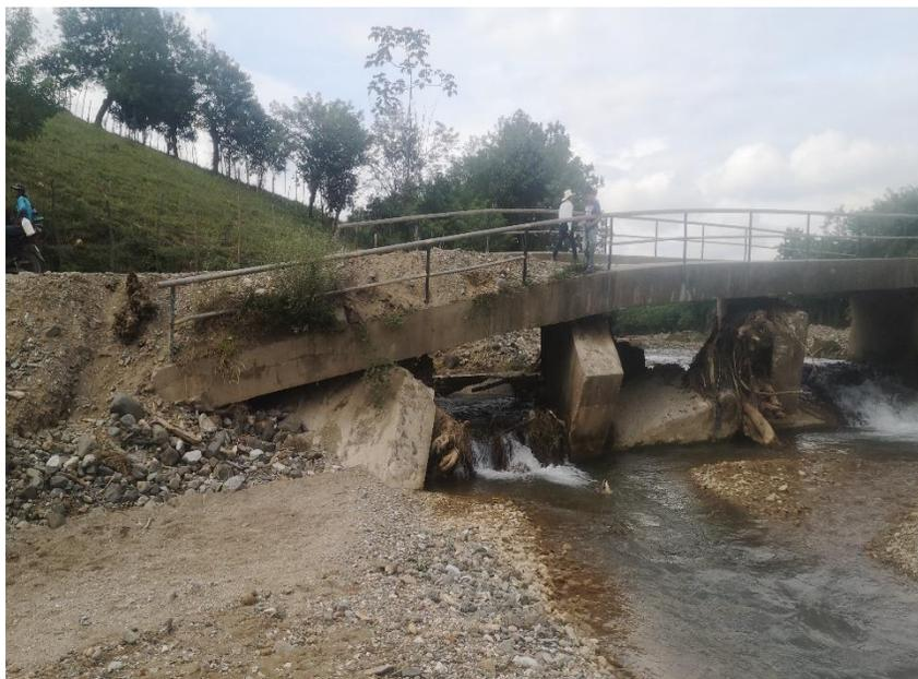
**Ilustración 5. Afectaciones en las alas del estribo del puente.**
