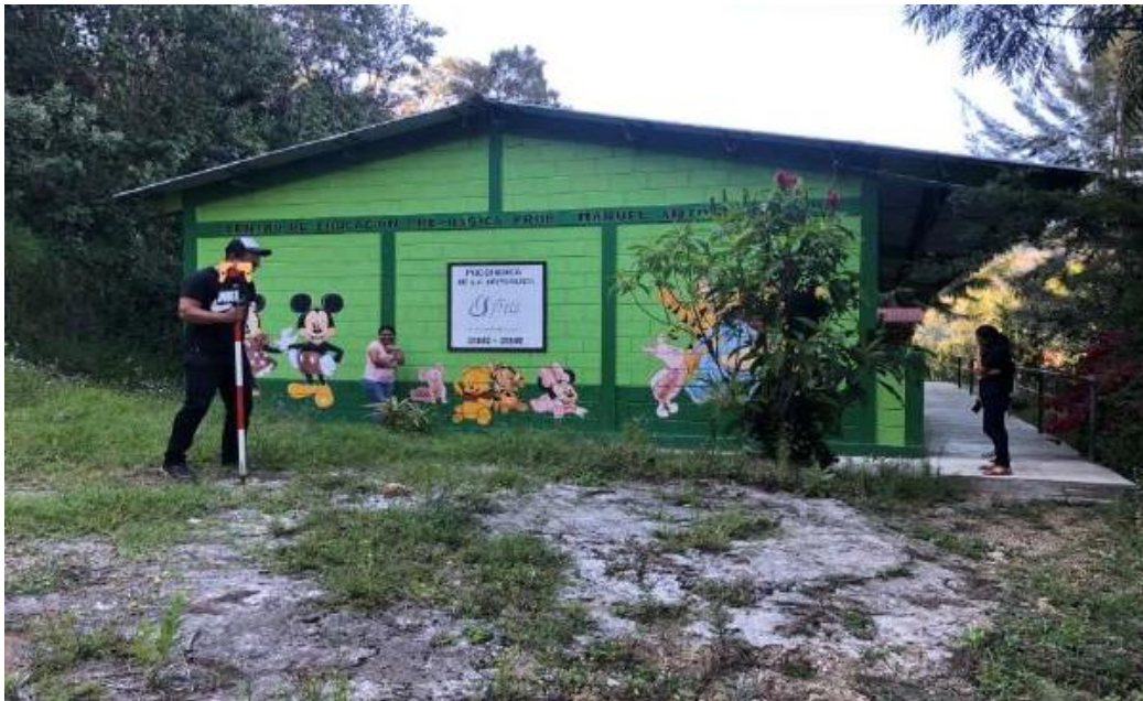
Ilustración 6. Vista de fachada del CEPB
