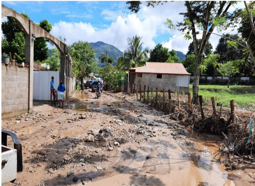
Ilustración 41. El caudal del río Chamelecón inundó las zonas aledañas a la estructura existente como se observa en la calle del acceso del costado Este (ingresando por la CA-4)
