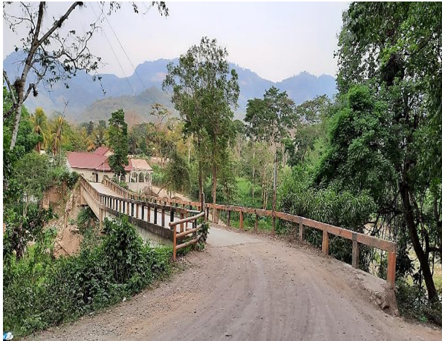
Ilustración 45. Panorámica del puente existente desde la aproximación Oeste.
