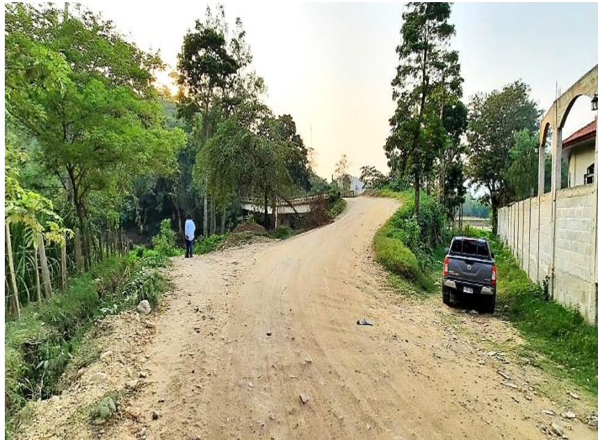
Ilustración 43. Vista frontal del sitio propuesto para la construcción del estribo Este de la nueva estructura (al lado izquierdo de la imagen).
