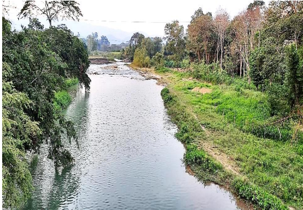
Ilustración 26. cauce del río Chamelecón aguas abajo de la ubicación de la nueva estructura.
