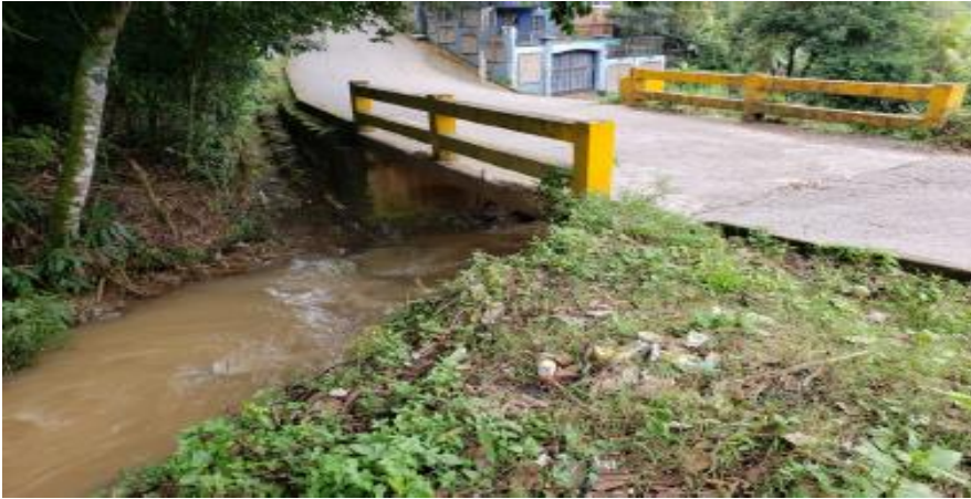
Entrada de agua al puente
