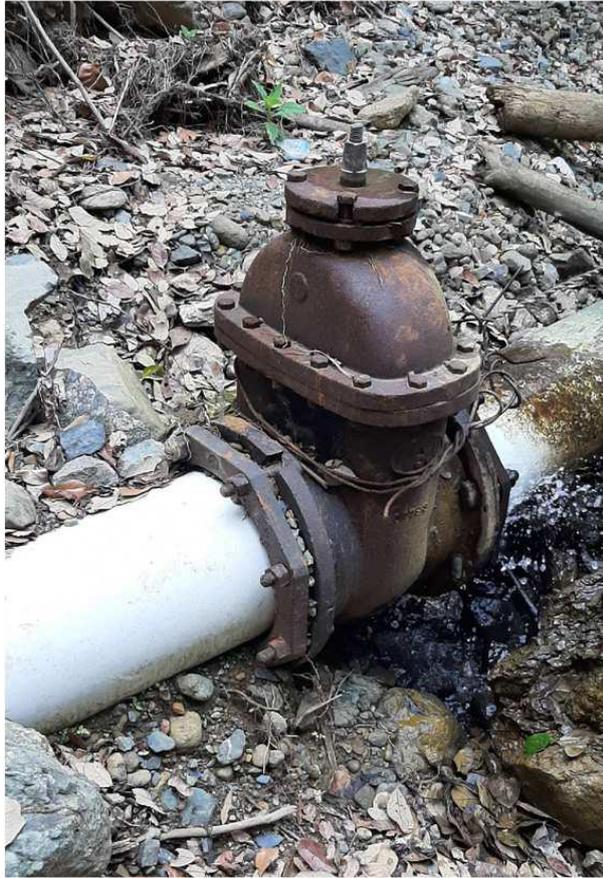
Accesorios dañados como ser codos, válvulas de control en manivelas originales, dañadas por el desacople y antigüedad del mismo elemento.
