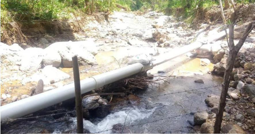
Tramo de tubería expuesto sobre quebrada, esto debido a que fue una reparación inmediata con material nacional (PVC).
