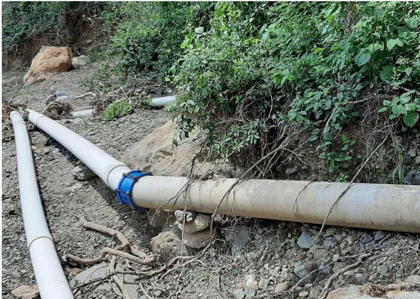
Tramo en el cual se aprecia tubería de asbesto con PVC, el cual debe cambiarse por otro material ya que es altamente toxico.
