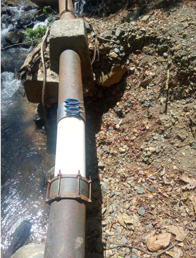
Remiendos de sistema en tramos a intervenir, se observa la reparación temporal con PVC en un tramo donde va tubería de HG en mal estado.
