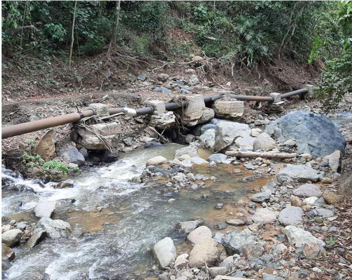
Tramo desacoplado justamente después de las tormentas tropicales Eta e Iota, la saturación del suelo provocaron erosiones en este punto.
