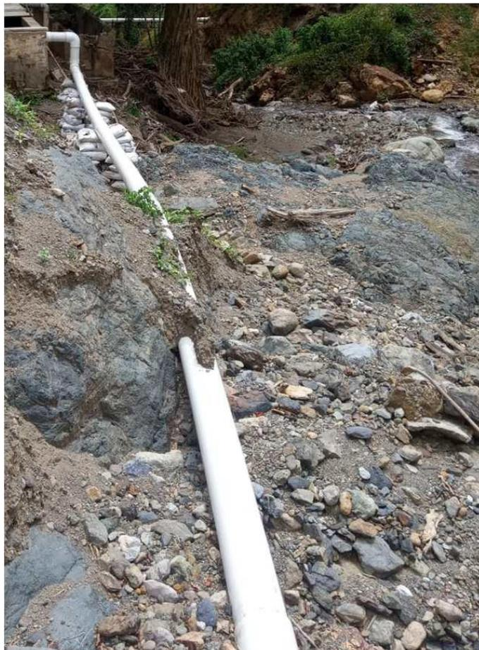
Como se aprecia en la imagen, la tubería de PVC se encuentra al descubierto/expuesta a daño continuo por alguna roca o por el mismo sol.
