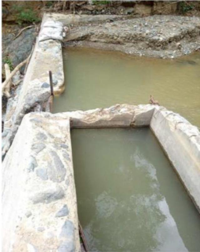
Daño en estructuras existentes, sedimento que al momento de las tormentas ETA e IOTA se encontraba en arrastrado por corrientes causadas por las copiosas lluvias.
