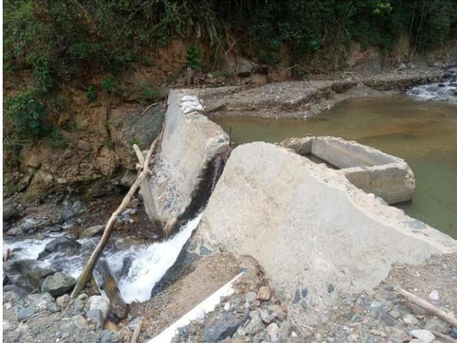
Fotografía de la Obra de Toma de Matazano después de las tormentas tropicales Eta e Iota. Se puede apreciar daños como fisuras y desgastes de la estructura de concreto en los bordes.
