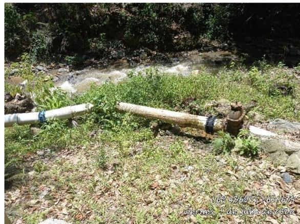
**Ilustración 4. Tubería dañada**
