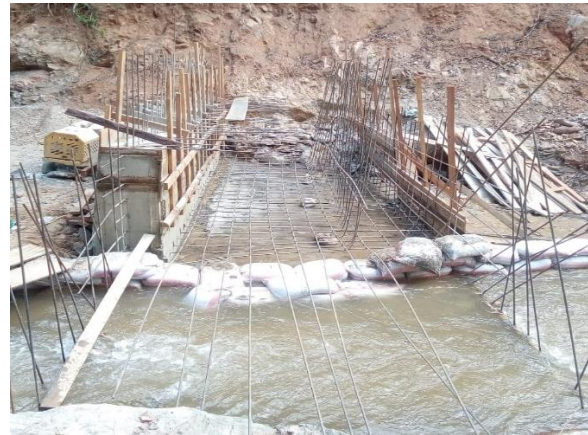
Ilustración 6. Obra toma que se va a reparar
