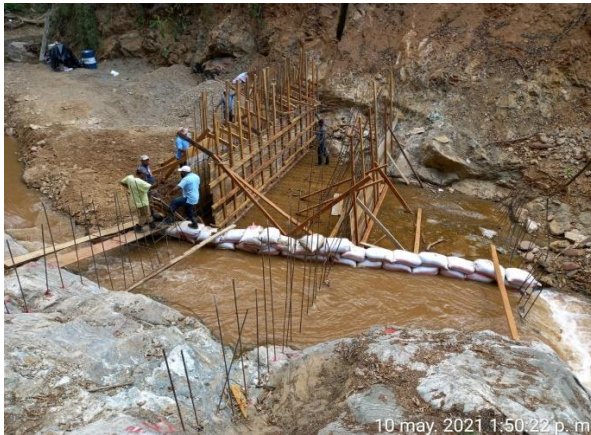
Ilustración 6. Obra toma que se va a reparar
